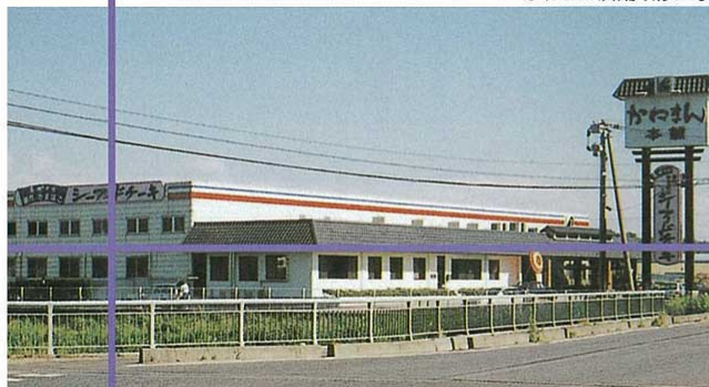
かねまん店舗改修工事
